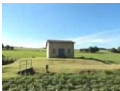
Station de pompage de Dompierre-aux-Bois
