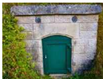
Captage source de Mexico Haute
