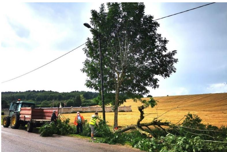
Elagage en régie 02 août pour permettre l'installation des câbles de fibre sur les poteaux.
